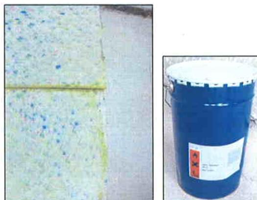
**Imágenes 12 y 13 Instalación de los paneles AGLOPUR 400/40 sobre la pared y cola empleada**
