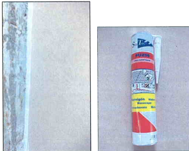
Imágenes 21 y 22 Sellado perimetral y masilla de poliuretano utilizada
