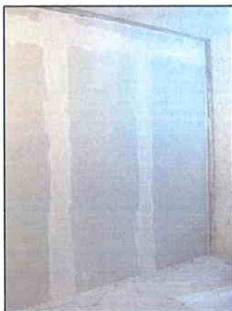
Imágenes 31, 32 y 33 Sellado de las juntas entre placas y sellado perimetral
