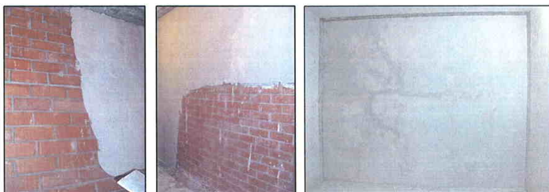
Imágenes 6, 7 y 8 Proceso de enyesado de la pared
