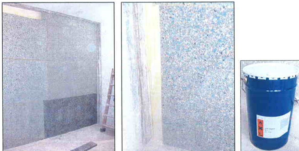
Imágenes 11, 12 y 13 Instalación de los paneles AGLOPUR 80/40 sobre la pared y cola de contacto utilizada
