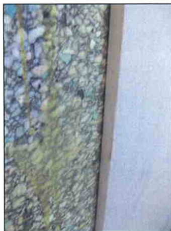
Imágenes 28, 29 y 30 PYL de 15 mm y su encolado sobre el panel AGLOPUR 150/20
