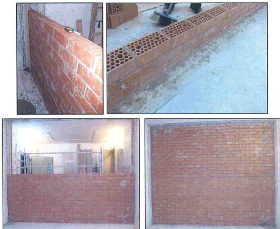
Imágenes 2, 3, 4 y 5 Proceso de construcción de la pared de ladrillo
