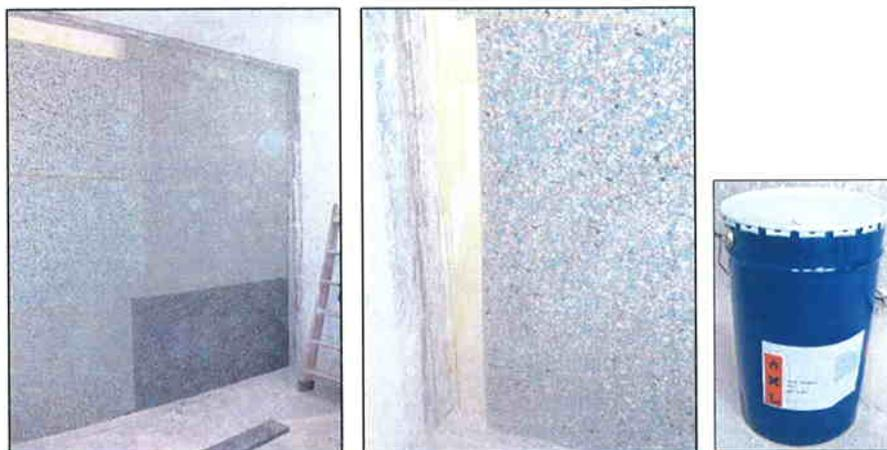
**Imágenes 11, 12 y 13 Instalación de los paneles AGLOPUR 80/40 sobre una de las caras de la pared y cola de contacto utilizada**
