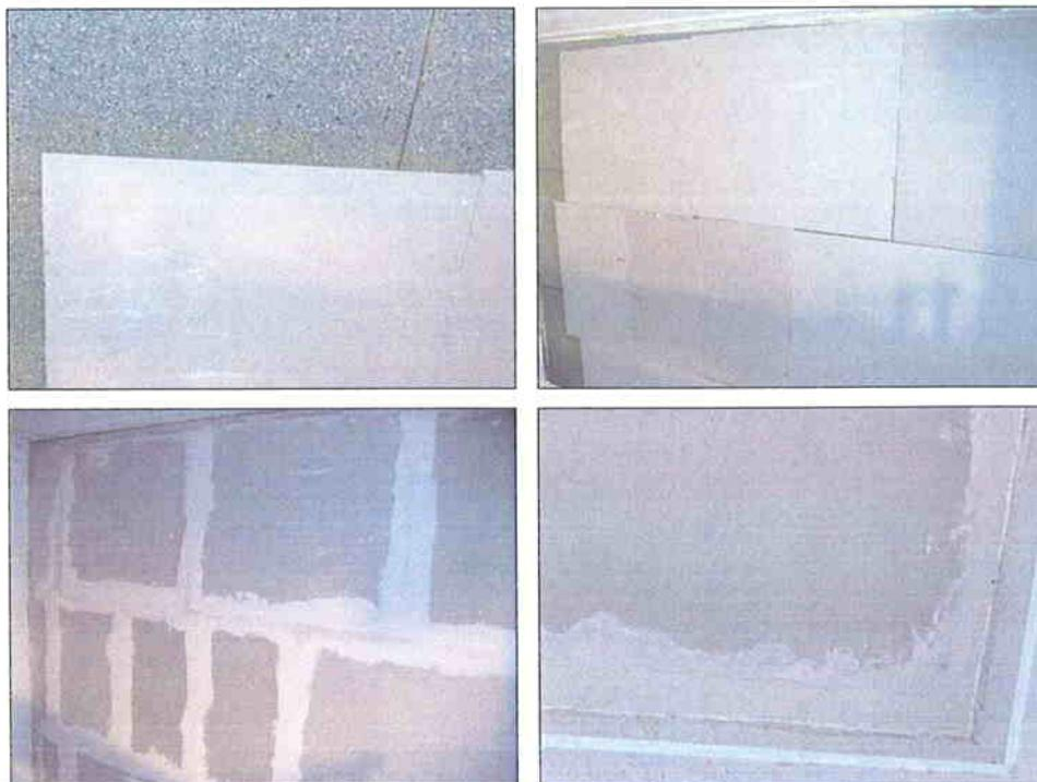
**Imágenes 15, 16, 17 y 18 Colocación de las PYL y detalle del sellado entre ellas**
