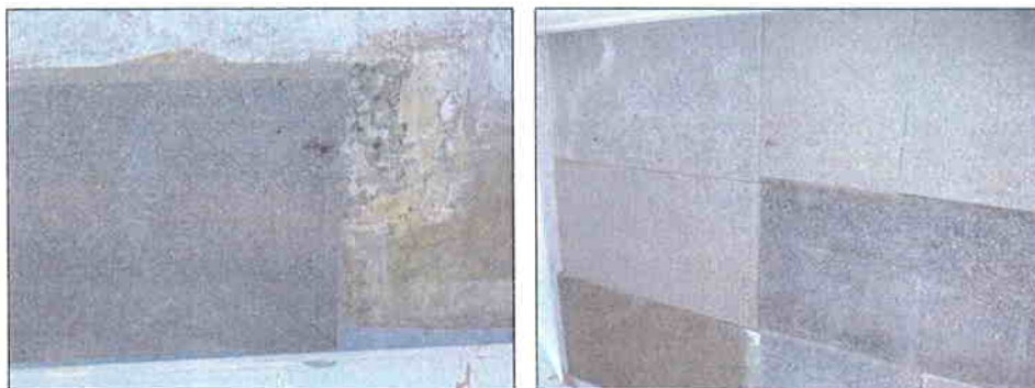
Imágenes 5 y 6 Encolado de los paneles AGLOPUR 80/80 al forjado
