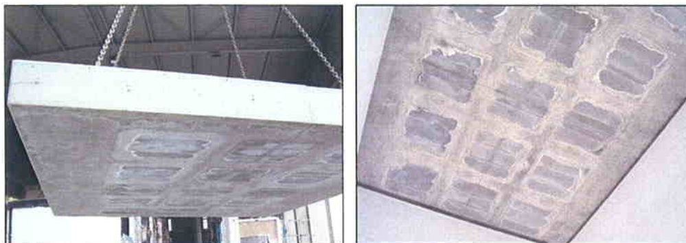
Imágenes 1 y 2 Forjado de hormigón armado
