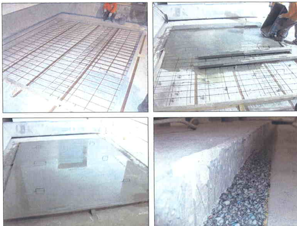
Imágenes 3, 4, 5 y 6 Detalles de la construcción de la losa y colocación de los paneles
