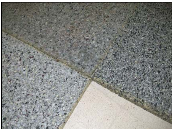
Imágenes 3 y 4. Detalle del encuentro de los paneles y muestra preparada para el ensayo
