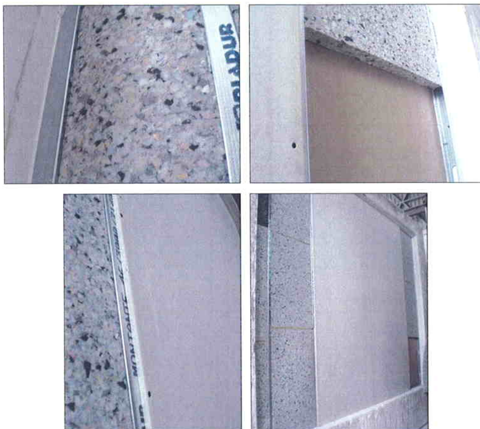
Imágenes 20, 21, 22 y 23 Colocación de la espuma AGLOPUR y de la segunda capa de PYL
