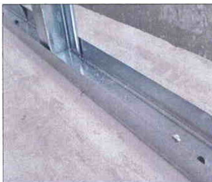
Imágenes 10, 11 y 12 Detalles del canal inferior, su sellado con el marco portamuestras y de un montante lateral también sellado, respectivamente
