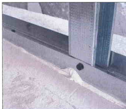
Imágenes 10, 11 y 12 Detalles del canal inferior, su sellado con el marco portamuestras y de un montante lateral también sellado, respectivamente
