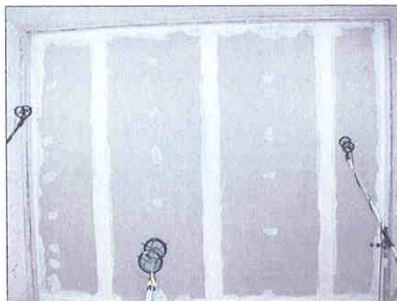
Imagen 24 Cerramiento finalizado y preparado para el ensayo
